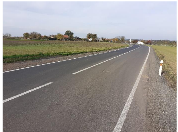
Foto po stavbě:
