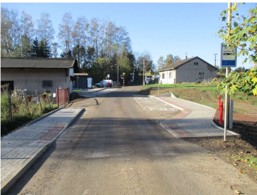
Foto po stavbě:
